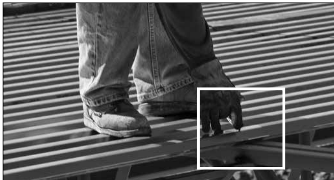
Marquage du panneau de tablier métallique pour indiquer où se trouve l'acier support
