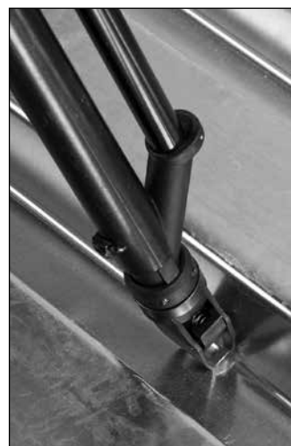
Utiliser les nervures du tablier comme butée de vissage afin de réduire le risque que l'outil ne glisse.
