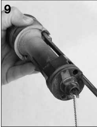
9 Brosser la chambre de combustion.
