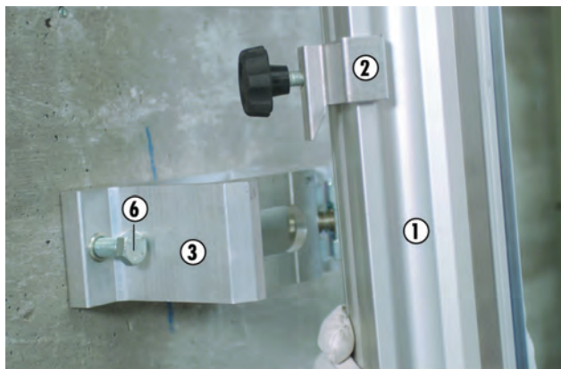
Skenfotsmontage med standardskenfot
